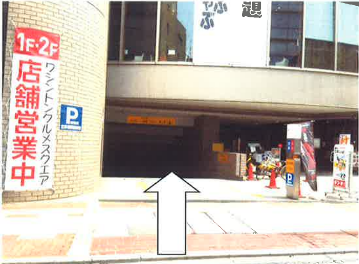
地下立体駐車場 スロープを下る
