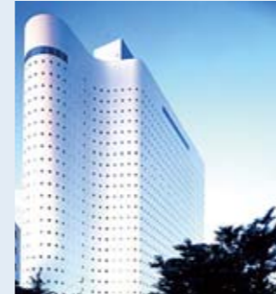
新宿ワシントンホテル本館
